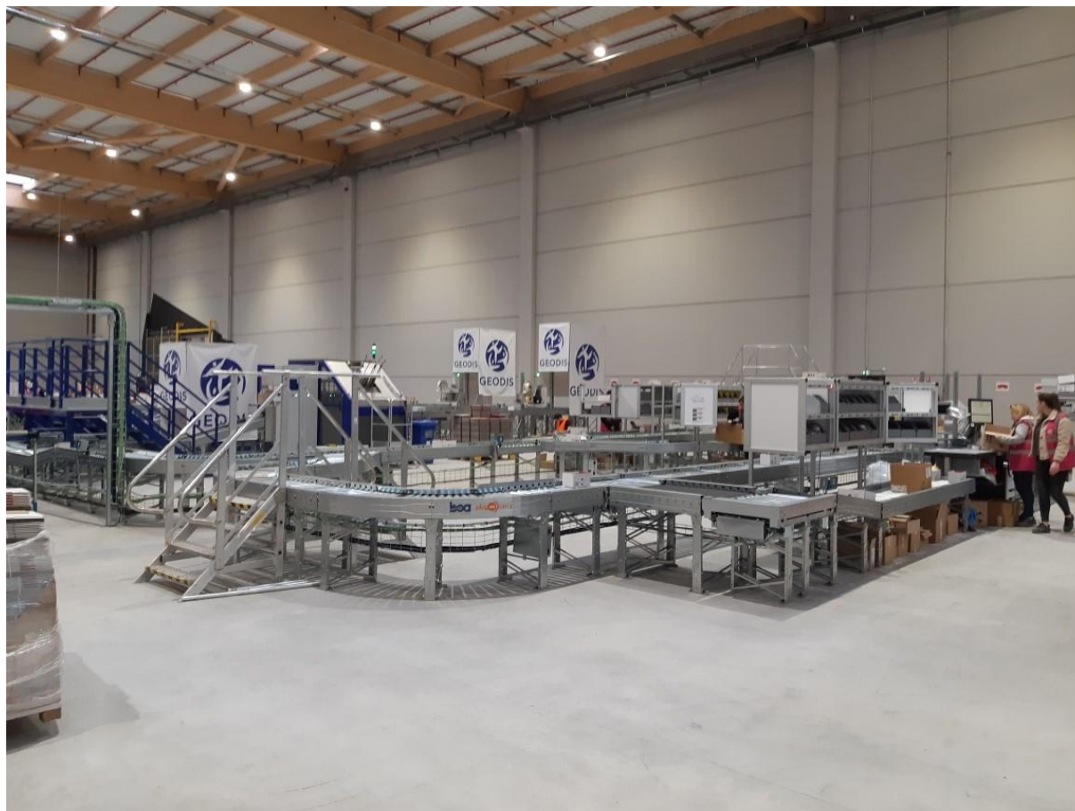
Nouvelle ligne Plug-and-Carry® BOA Concept – Site GEODIS Douvrin
